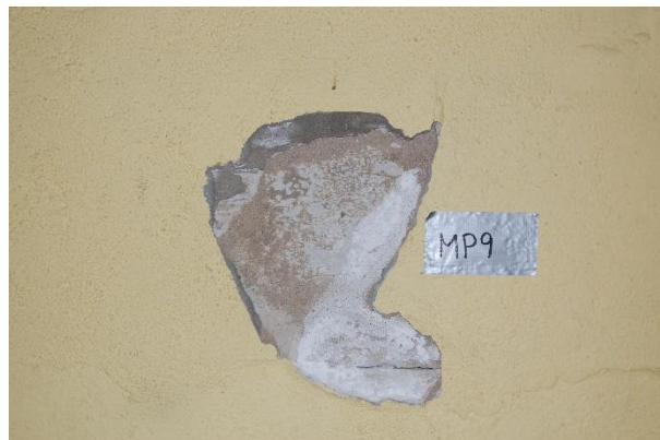
Figur 8. Puss/maling på siporexvegg i garasjen. MP9.
