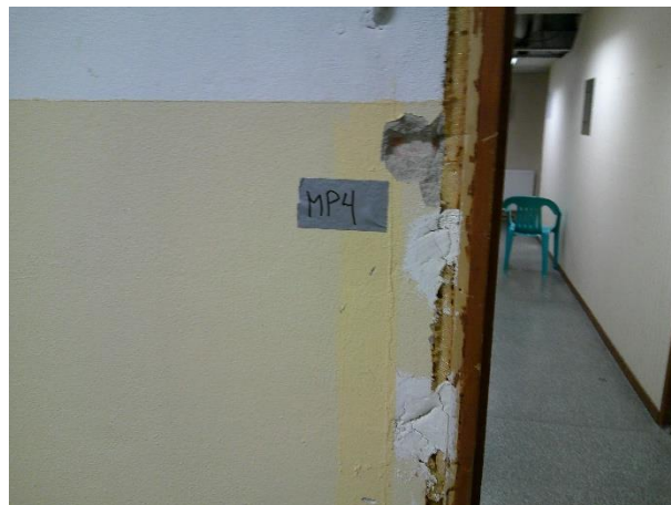
Figur 4. Maling/puss på teglvegg, kontordel øst. MP4.
