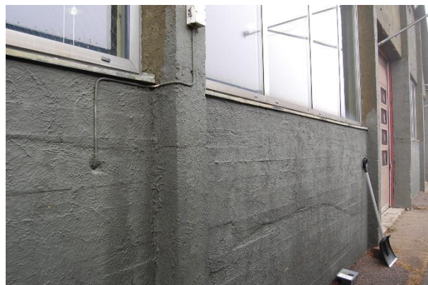
Figur 10. Maling på utvendig betongvegg. MP14.
