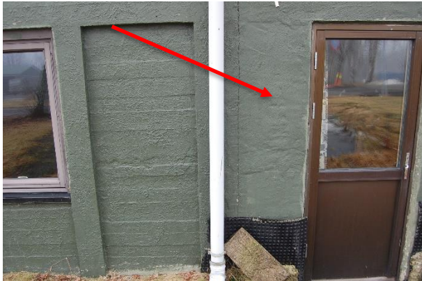
Figur 11. Maling på utvendig lecavegg. MP15.
